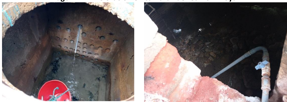
Imagen N° 11: Cloración en cámara de reunión Moya I
