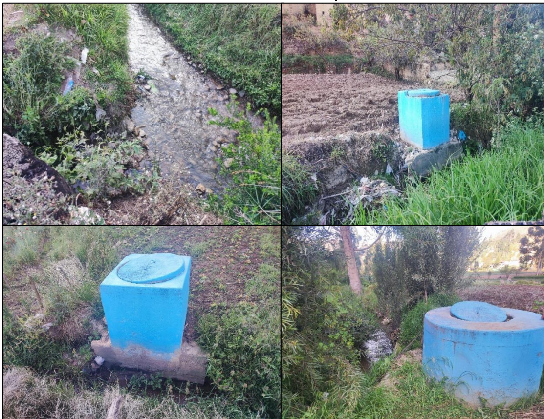
Imagen N° 28: Cámaras de reunión de captación Moya II, afectadas por crecida de caudal de riachuelo Huantay
