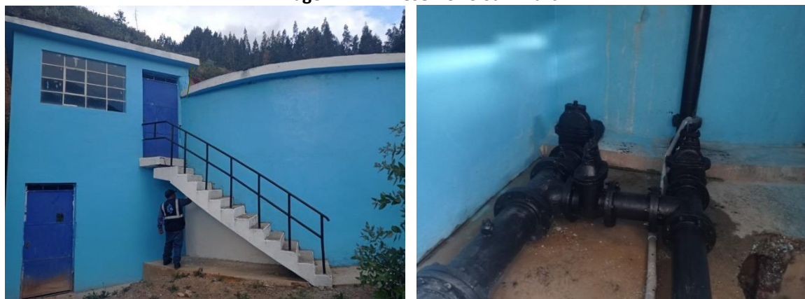
Imagen N° 17: Reservorio San Martin
