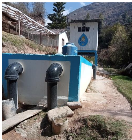
Salida del sedimentador
